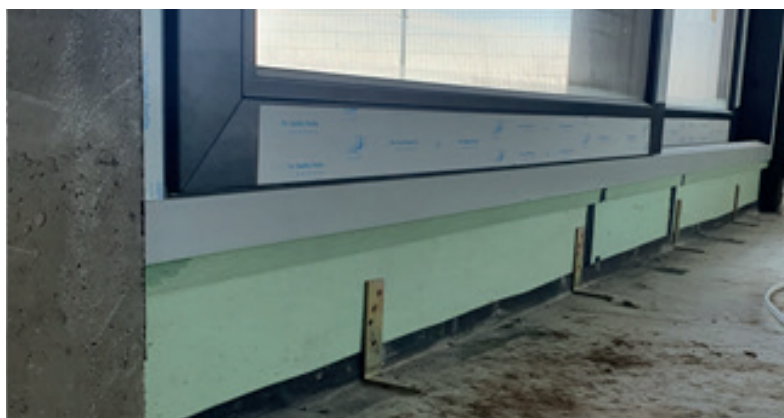
FMW 150x160x30 Łącznik Kątowy KNELSEN 150 Służy do łączenia podwaliny z posadzką.
